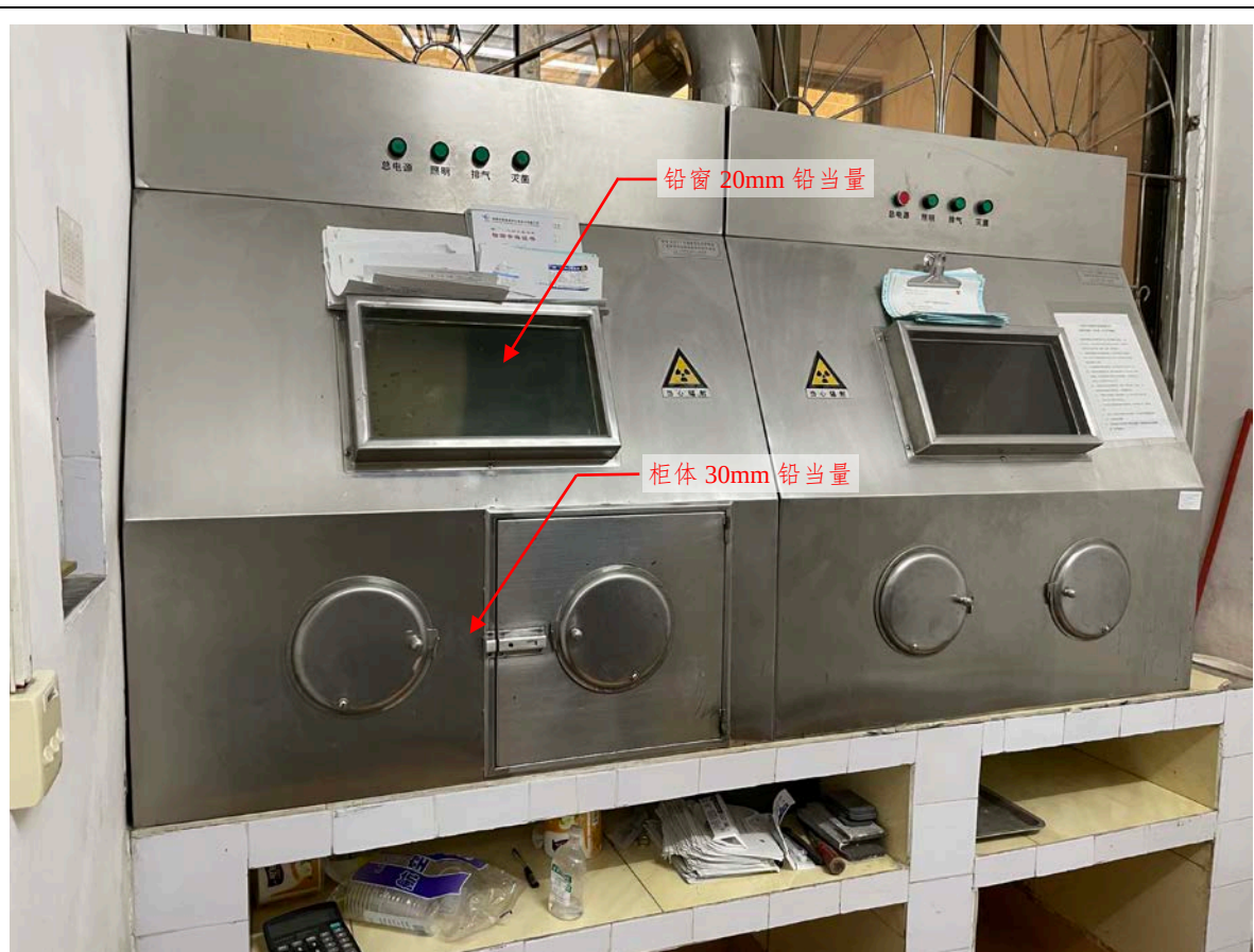
图 2-12 核医学科二层 ^{131}\text{I} 分装柜屏蔽防护示意图
