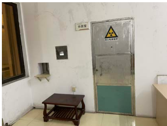
图 3-5 碘分装室防护门及服药窗口
