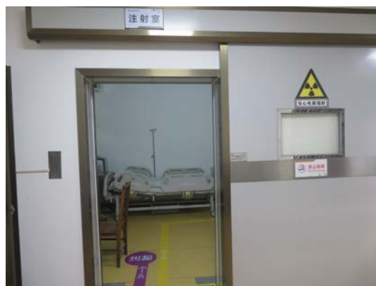
图 3-2 注射室入口防护门
