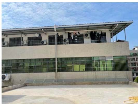
图 2-26 ^{131}\text{I} 专用通风柜楼外排风管道
