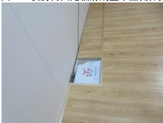
图 3-7 机房内线缆沟穿墙处
